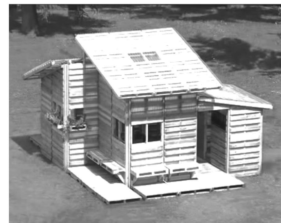
slika3 : prikaz izvedenog projekta
